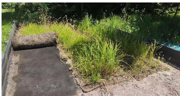
→ Transport facilité par roulage des nattes
